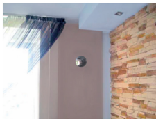
Wzór montowania układu wentylacji dolotowo-wyciągowej PRANA 150, PRANA 200.
