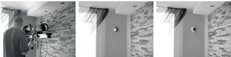
Rys. 5 Przykład montażu rekuperatora «PRANA-200C».
